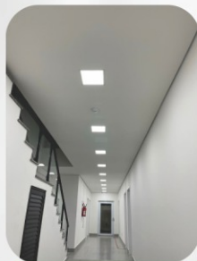
Forro em Drywall
